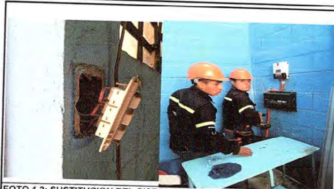
FOTO 1.2: SUSTITUCION DEL SISTEMA ELECTRICO
