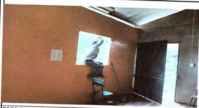
FOTO 1: SUSTITUCION DE VENTANAS DE LA COCINA
