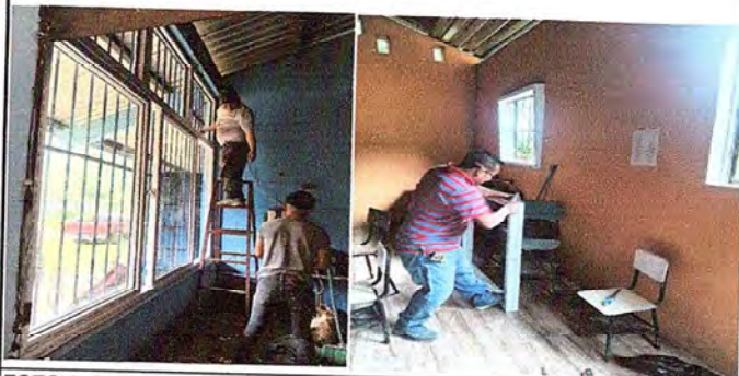
FOTO 1: SUSTITUCION DE VENTANAS A PCV
