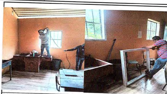
FOTO 1.2: SUSTITUCION DE VENTANAS A PVC
