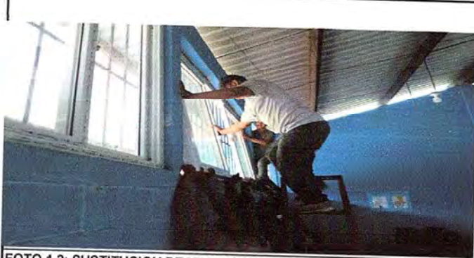
FOTO 1.2: SUSTITUCION DE VENTANAS A PCV
