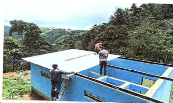
FOTO 1.2: ENTECHADO DE LAMINA DE SERVICIOS SANITARIOS
