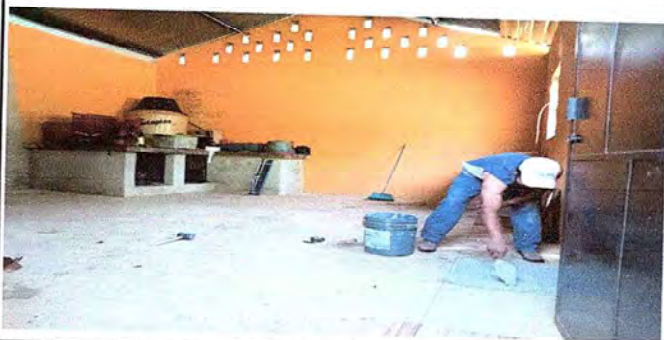
FOTO 1: SUSTITUCION DE PISO A CERAMICO
