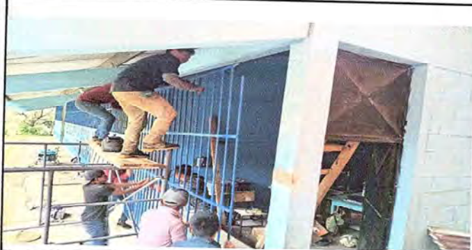
FOTO 1: SUSTITUCION DE BALCONES
