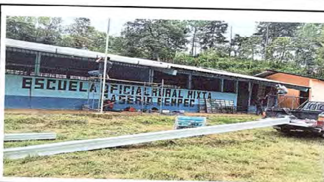
FOTO 1.2: SUSTICION DE CANAL BAJADA DE AGUA PLUVIAL
