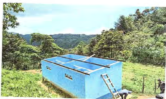
FOTO 1: SUSTITUCION DE LAMINAS DE SERVICIOS SANITARIOS
