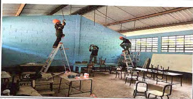
FOTO 1: SUSTITUCION DEL SISTEMA ELECTRICO
