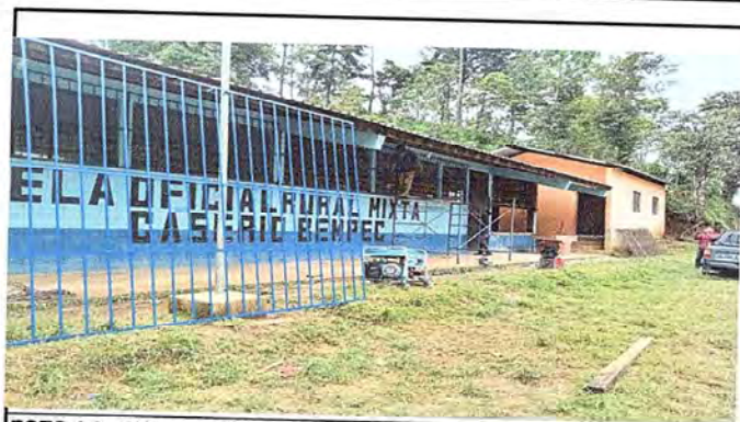
FOTO 1.2: SUSTITUCION DE BALCONES
